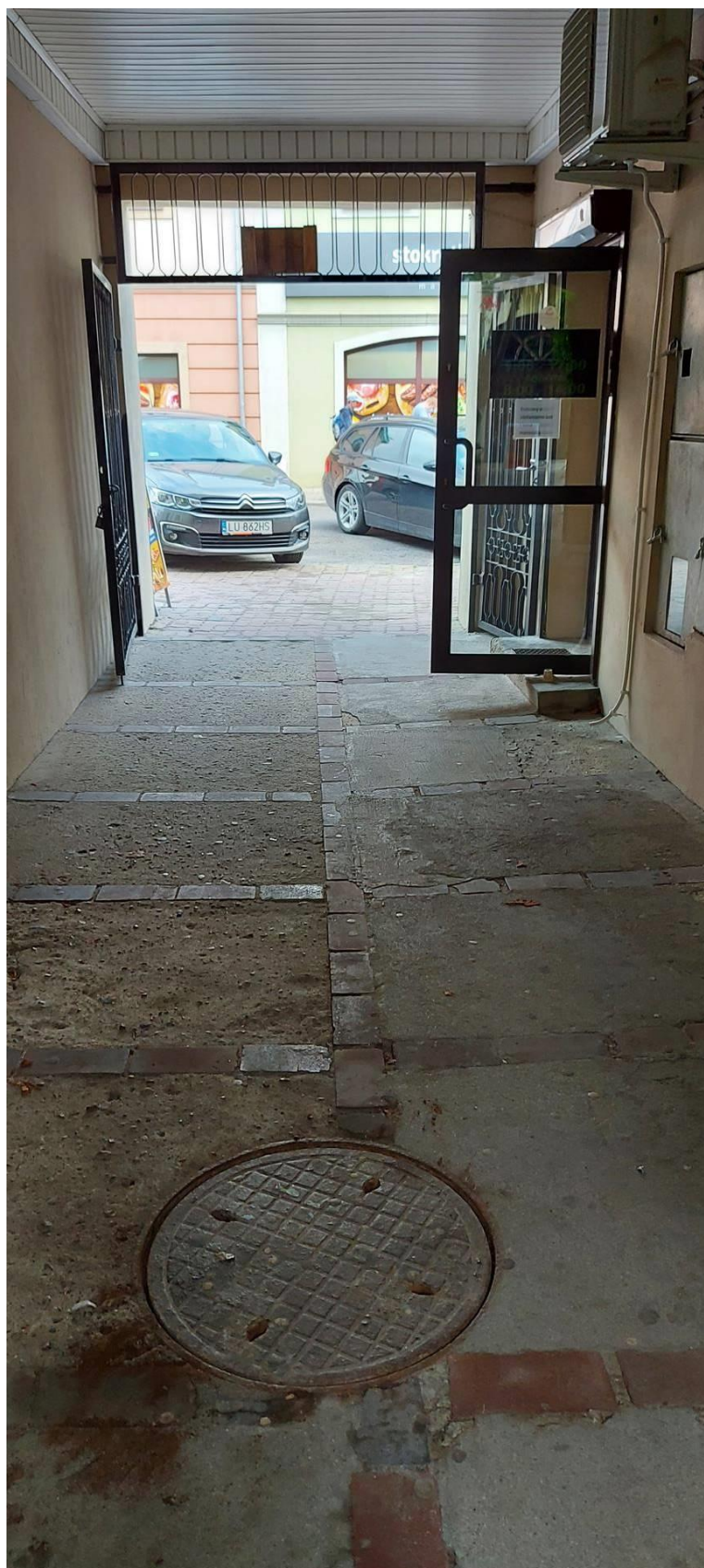
Foto 6. Miejsce awarii ul. Czysta w Krasnymstawie
